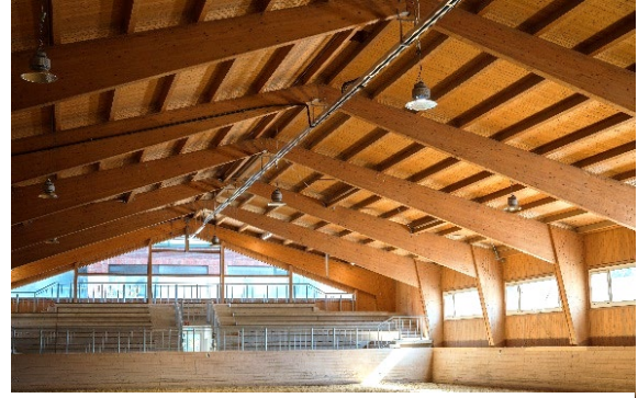
Umbau auf LED-Beleuchtung in der Reithalle © Thomas Suchanek / Vetmeduni
