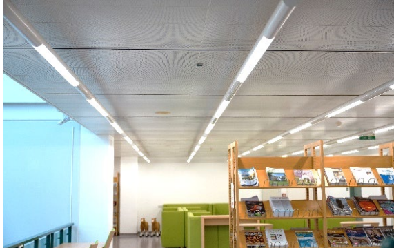
Umbau Auf LED-Beleuchtung in der Bibliothek @ Thomas Suchanek / Vetmeduni
